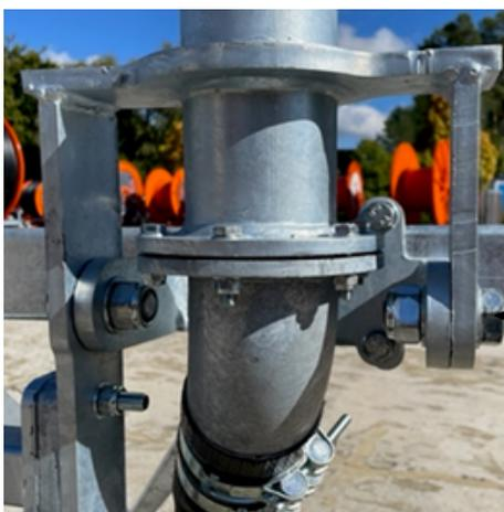
2. Hier das Regneranschlussrohr mit neuer gelaserter Drehaufnahme aus dickerem Material.
